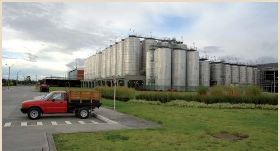
Tanques de fermentación de 6000 hl, 60 de ellos
